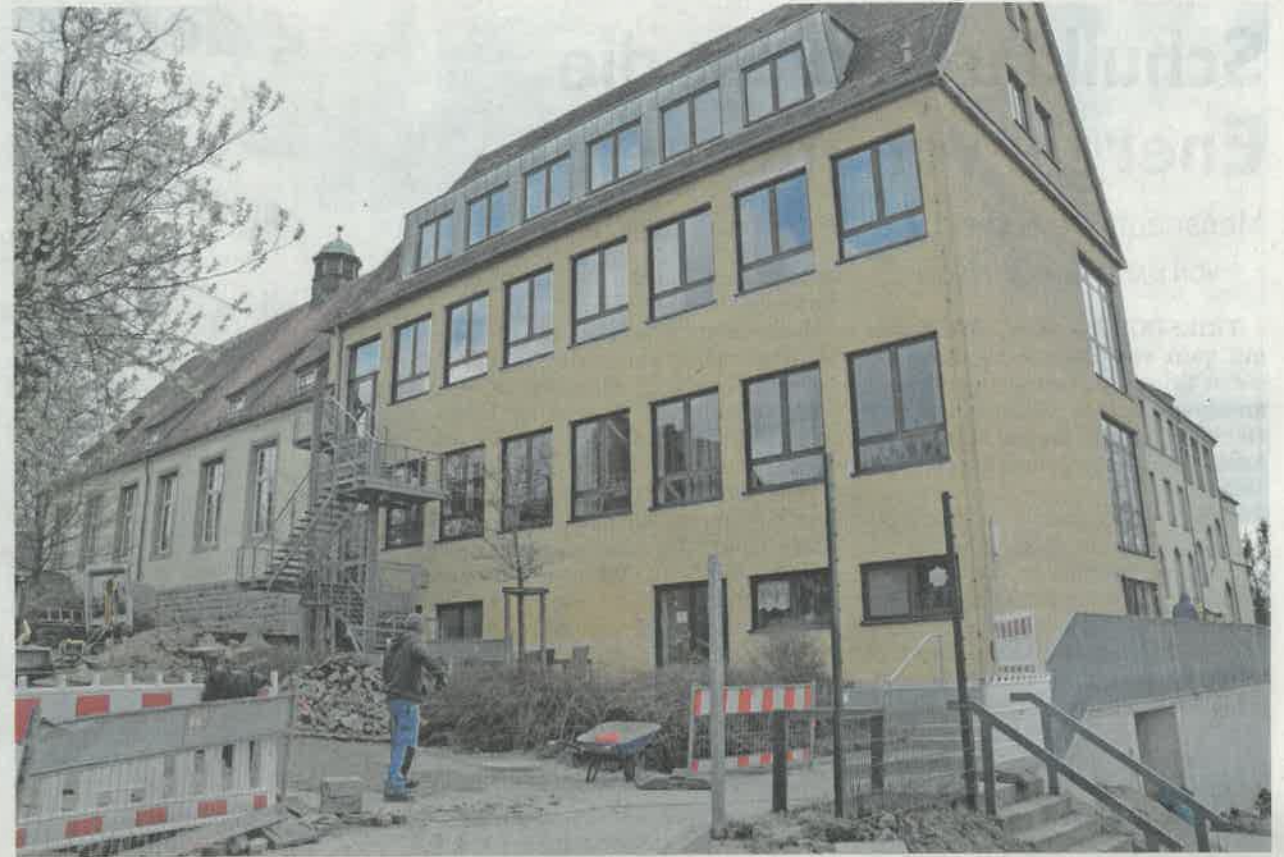
Bis in das Jahr 2020 hinein zieht sich die energetische Sanierung der Berufsschule über mehrere Bauabschnitte.
